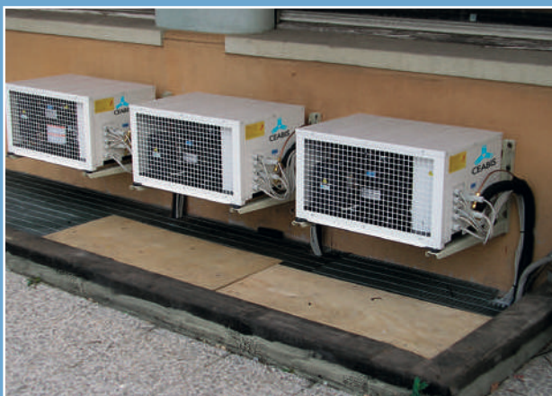
Gruppi frigoriferi di tipo remoto / Cooling units remote version
