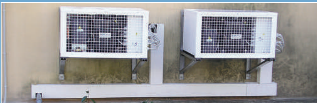
Unità frigorifere di tipo remoto / Cooling units remote version
