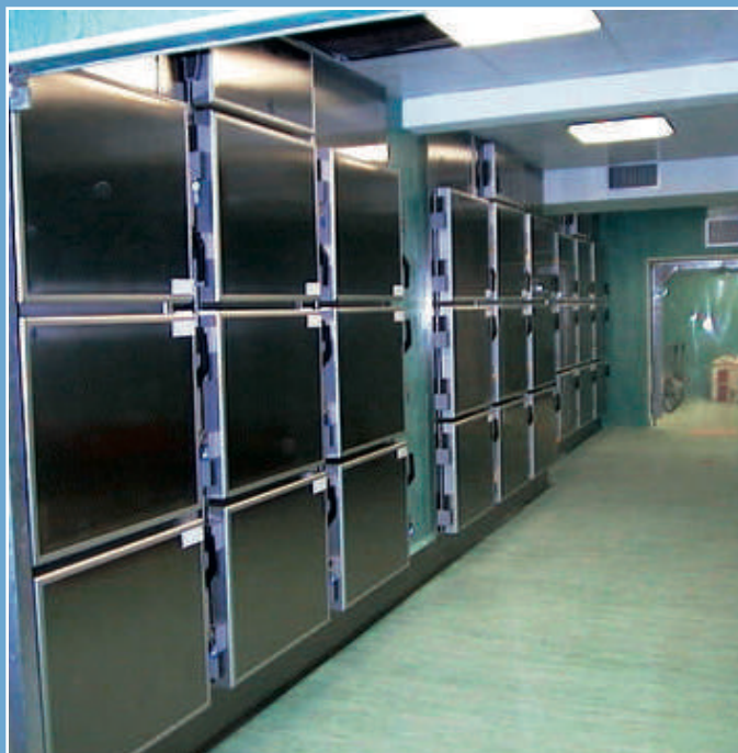
Gruppo celle a 9 posti cadauna, sportelli indipendenti, sportello per estrazione evaporatore
